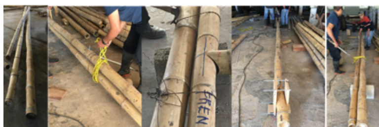
Figura 12. Amarres provisionales, sujeción de elementos para su fijación con varilla roscada.
