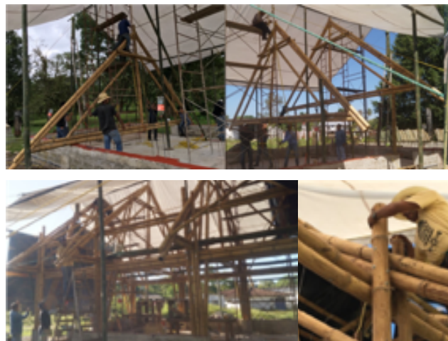
Figura 15. Rigidización de las armaduras, colocación de riostras longitudinales.
